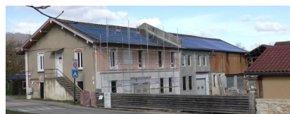
Cras : bâtiment « Aplomb »
